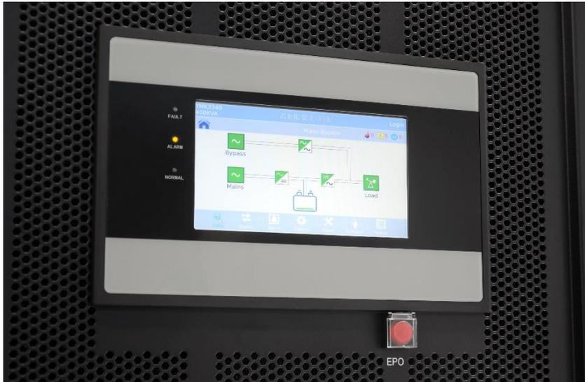
На панели управления с сенсорным экраном (верхнее изображение) отображается состояние ИБП, отдельных модулей и предупреждающие сообщения. Конфигурирование модулей ИБП и их тестирование также можно выполнить здесь.
