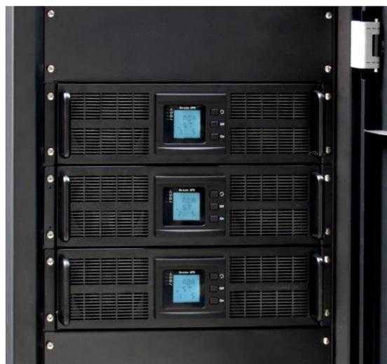
На центральный сенсорный экран с панелью управления (фото сверху) выводятся предупреждения и информация о рабочих состояниях ИБП и модулей. Помимо этого, здесь можно выполнить конфигурацию ИБП и его модулей, а также тесты. Кроме того, каждый модуль оснащен индивидуальным экраном, на котором отображается самая важная информация (фото справа).
